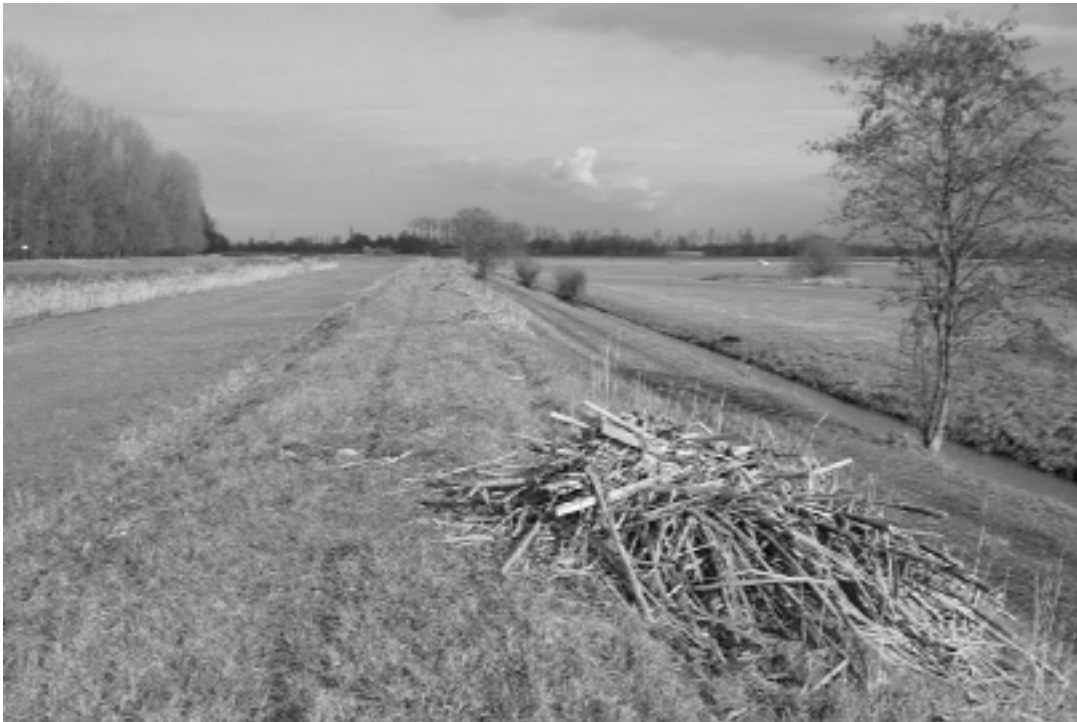
Abbildung 3: Der Renchflutkanal im Doppeltrapezprofil (Foto: Sandra Röck)
